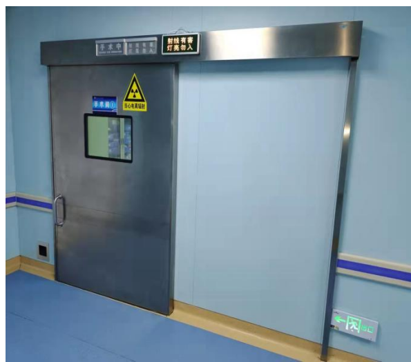
复合手术室机房受检者防护门
